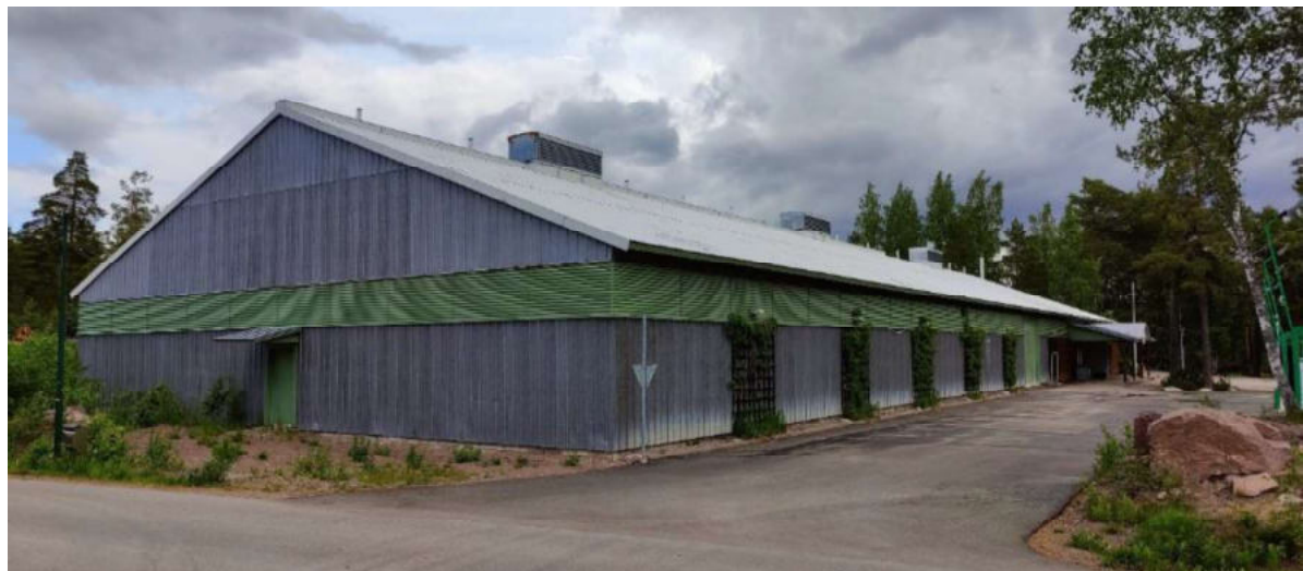
Ennen Pyroll Areenaa rakennus toimi ratsastusmaneesina.
