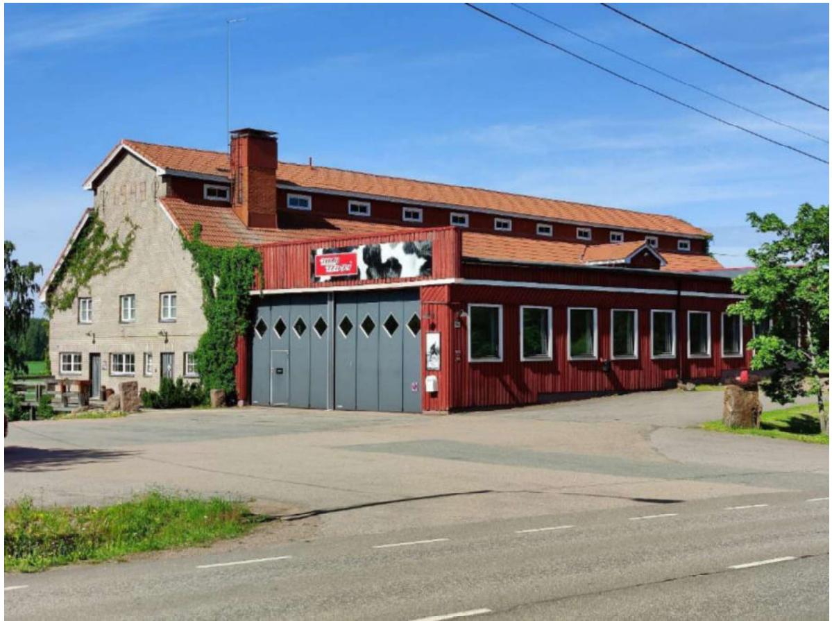
Siltakyläntien puoleiselle seinustalle on rakennettu kookas laajennusosa.
