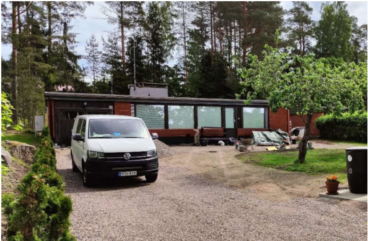
Kalarannantie 31–37 taloissa on suuret rannan suuntaan avautuvat ikkunat.
